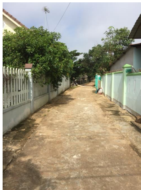
Tuyến đường bê tông trong khu dân cư
