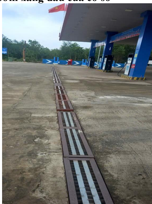
Hình 1.4: Rãnh thu gom nước mưa nhiễm xăng dầu
